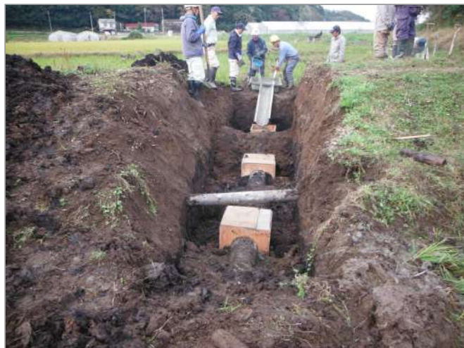
用水管の漏水修理
