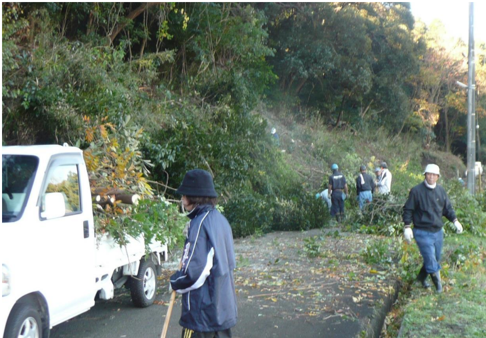
市道法面の支障木 伐採
