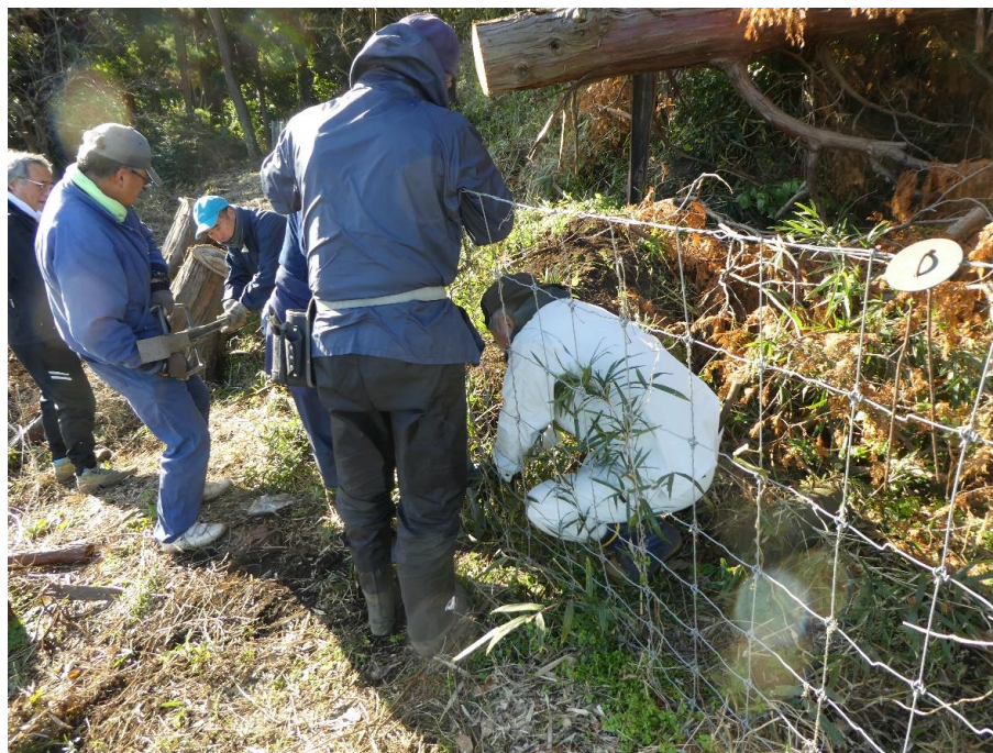
台風被害後の補修
