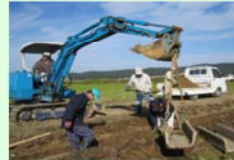
コンクリート水路の更新
