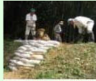
漏水箇所の補修
