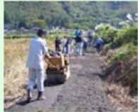
未舗装農道の舗装
